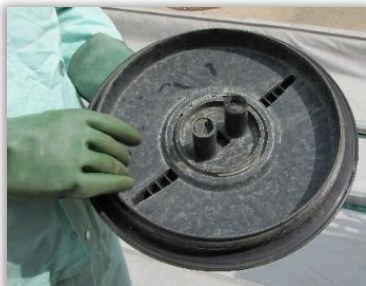
Rys. 26. Zawór napowietrzający pokrywy zbiornika.
